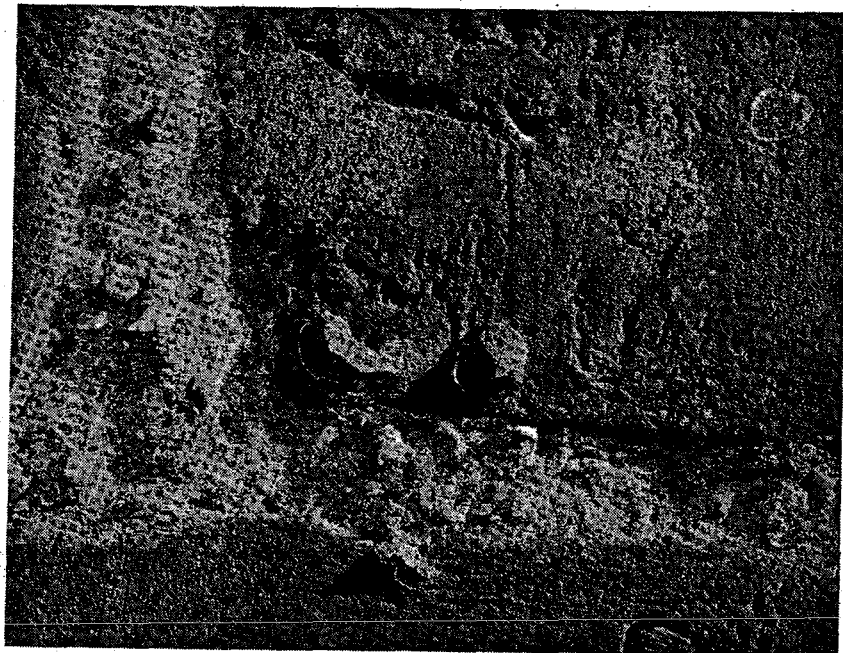
Fig. 23. Skorpedannelse paa røde haandstrøgne Sten, Muren er 18 Aar gammel.
